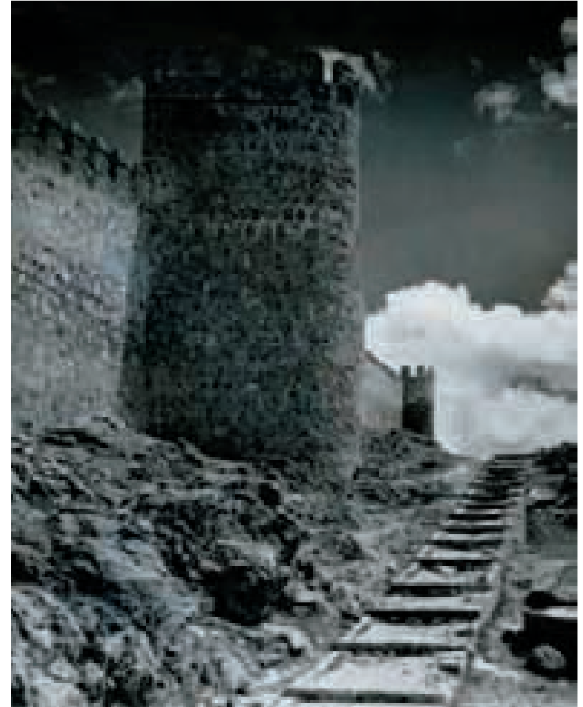
Escalinata construida por presos de la posguerra civil. Colec. Joaquín Hdez. Foto anónima. Hacia 1957.
