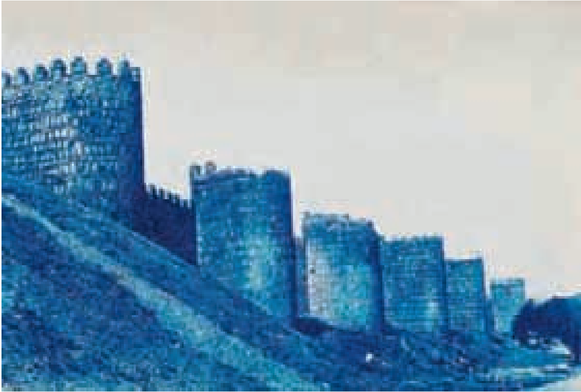
Lienzo norte de la muralla. Almenas desmochadas en los torreones. Foto Mayoral Encinar. Hacia 1915.
