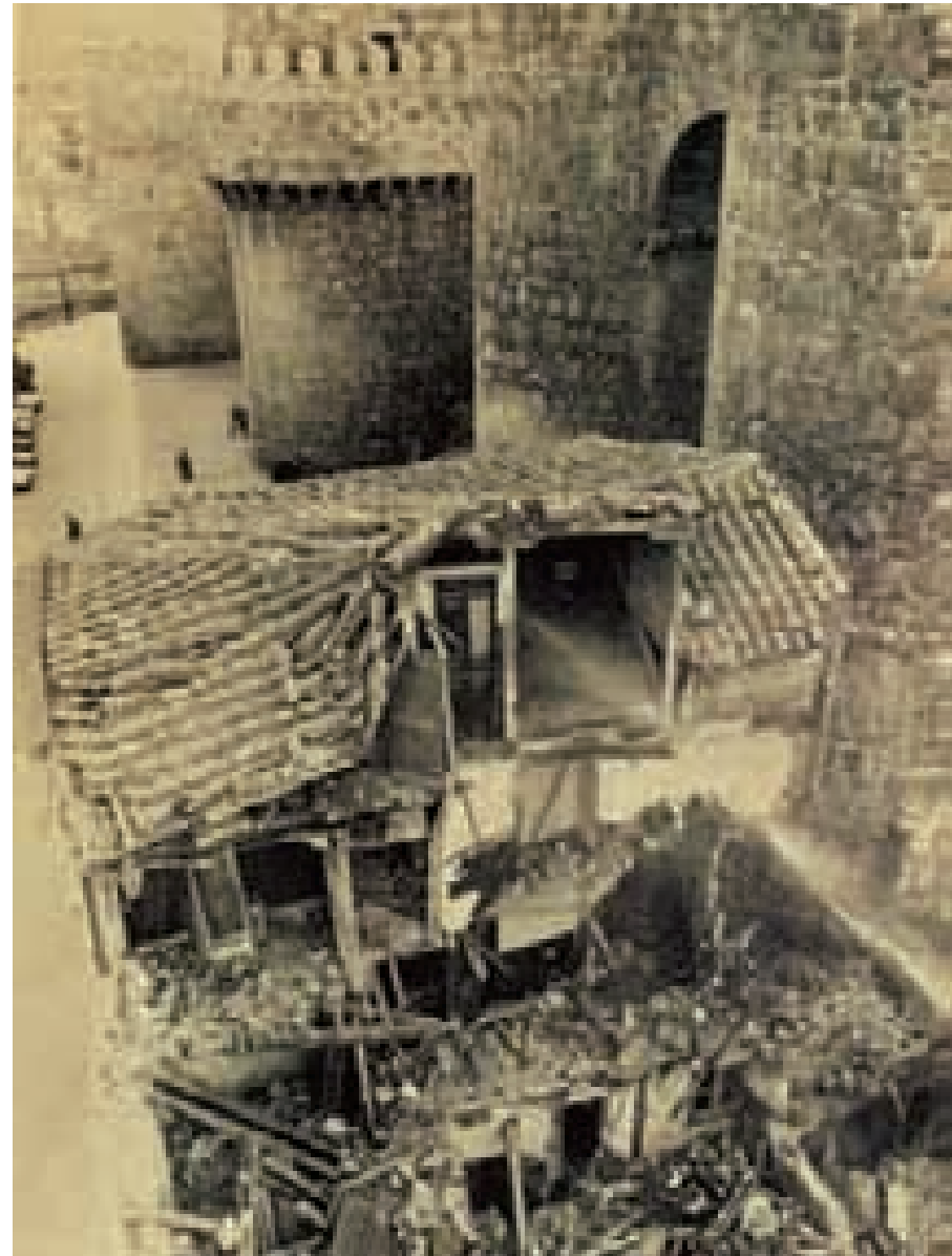
Demolición de edificios adosados a la muralla. Foto Javier Lumbreras, año 1981.
