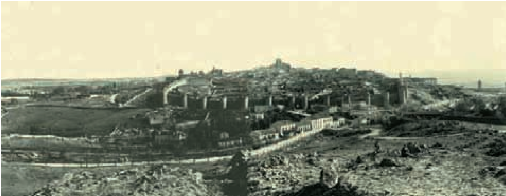
Vista panorámica del recinto amurallado. Foto Isidro Benito Domínguez. Hacia 1896.
