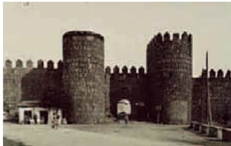
Puerta del Puente. Tarjetas postales. Fotos Loty. Hacia 1930.
