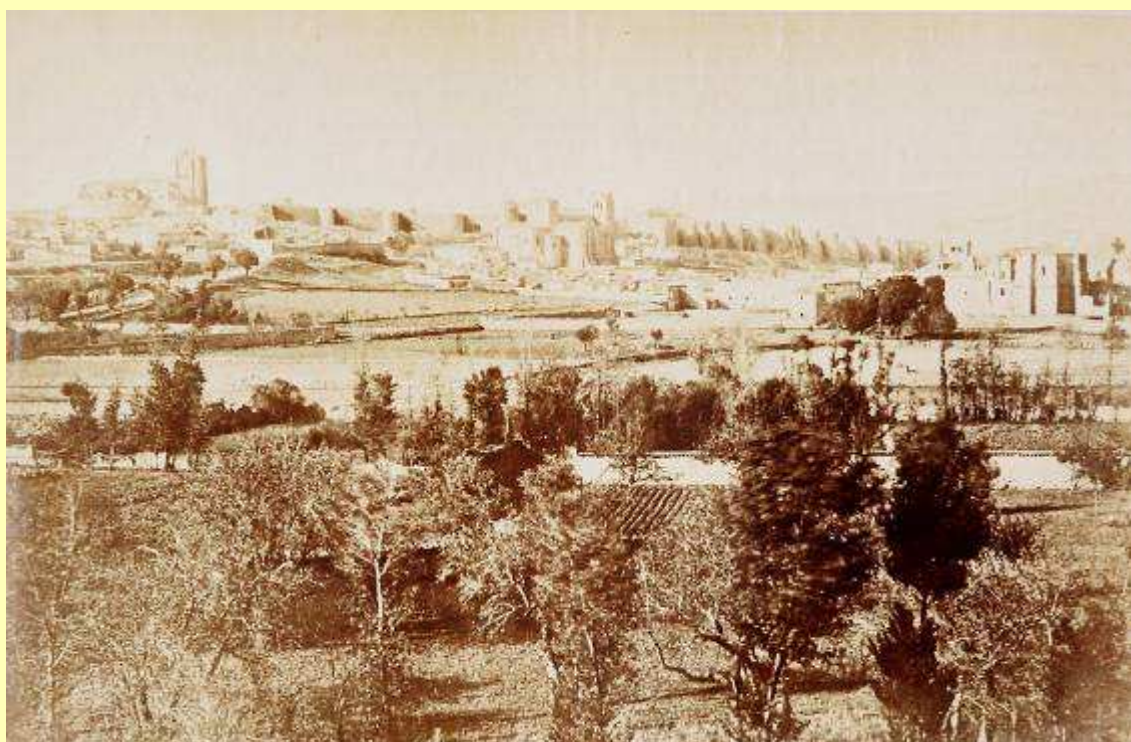
Vista general desde la línea ferroviaria. Foto Auguste Muriel, 1864.
