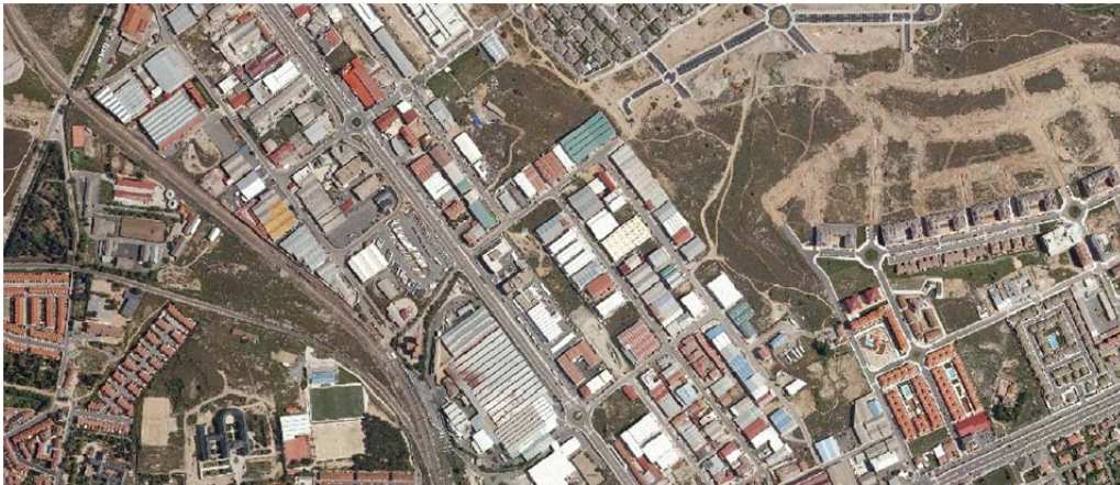
Polígono industrial Las Hervencias.
